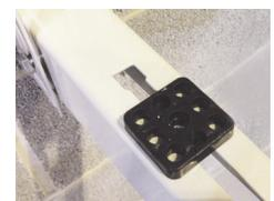
Verstellbare Körperschalldämpfer mit unverlierbarer Mutter
